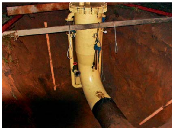
Fot. 1. | Starter czyszczaka
